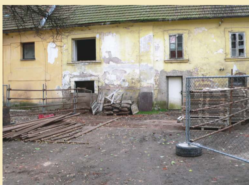
Průběh stavebních prací u DSJ
