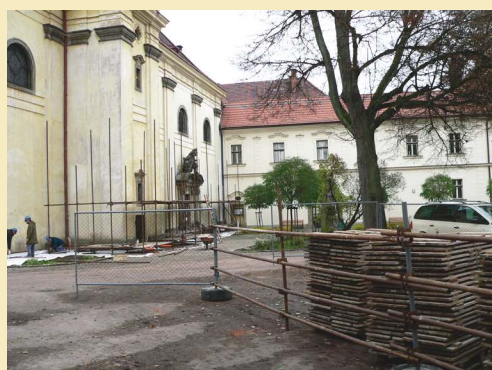
Zahájení stavby lešení na kostele
